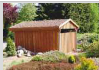
Deckelschalung sägerau, Lärche
