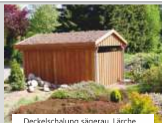
Deckelschalung sägerau, Lärche
